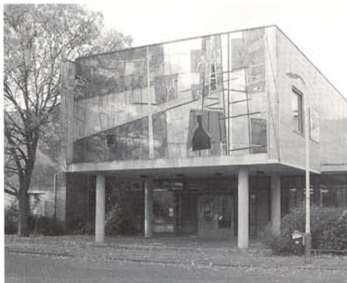
5 Mozaiek, Zuidlarenstraat 59, Den Haag, Jeroen Voskuyl, 1957. Deze school aan de Zuidlarenstraat blijft staan en daarmee is het kunstwerk gered. Foto: Wijnand Galema.
